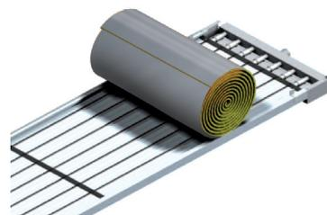
Un matelas isolant de 30 mm en fibre minérale est déroulé sur le panneau.
